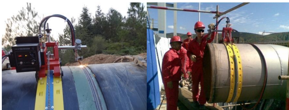
图四 STZQ-I 型的创新切法示意
